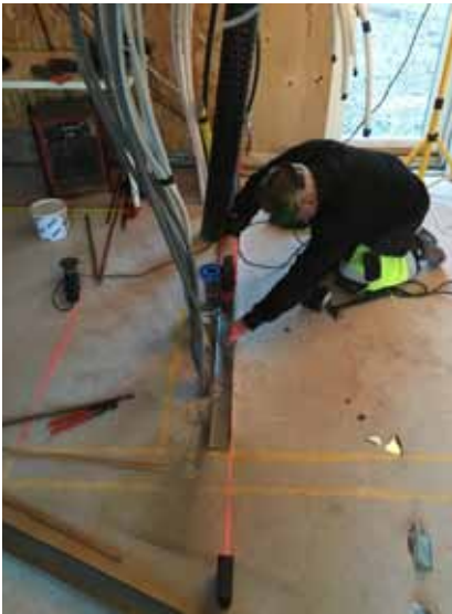
Här sätter min kompis Kenneth Norén dit golvet stålprofil. Profilen fästs med små spikmetallplugg. Det krävs därför 5mm borrningar i betongen med jämna mellanrum. Då bör man ta på sig hörselskydd - inte bara ha dem på huvudet :-)!
