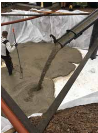
Armerad, lättflytande betong...
