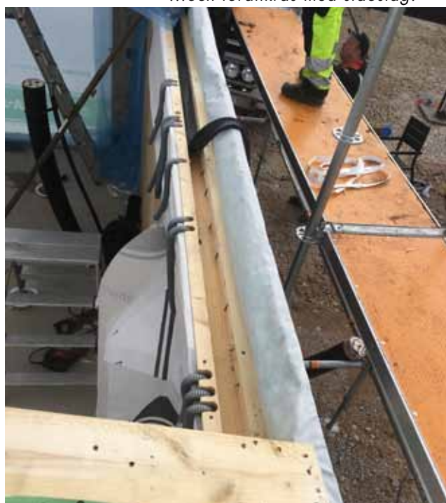
Takkassetternas montage förbereds med uppmonterad limträbalk som kassetten innehåller ursparning för. Väggblocken innehåller dessutom en fördjupning för takkassetternas styrlist. Allt förberett för enkelt montage.
