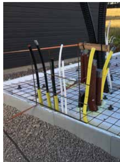
Rören hålls på plats med rep, plan- kor, armerings- och armeringsjärn.
