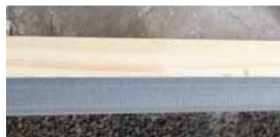
Under styrlisten monteras en syllisoler.
