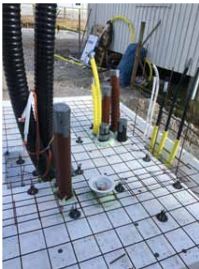
Många rör blir det...
