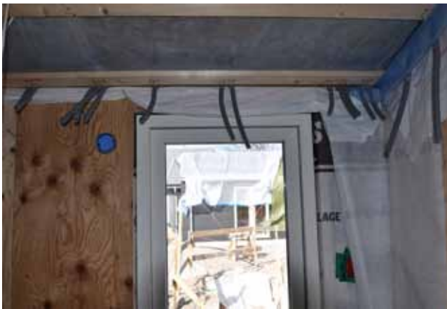
Rören vid dörren ansluter jag till med skarvmuff och går vidare i taket
