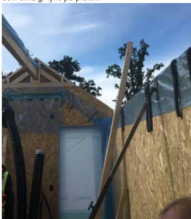
Takkassetternas montage förbereds med uppmonterad limträbalk som kassetten innehåller ursparning för. Väggblocken innehåller dessutom en fördjupning för takkassetternas styrlist. Allt förberett för enkelt montage.
