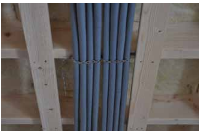
Exempel på förläggning på mellanbjälklaget. Flexslangen som förläggs fästs upp mellan glespanelen.
