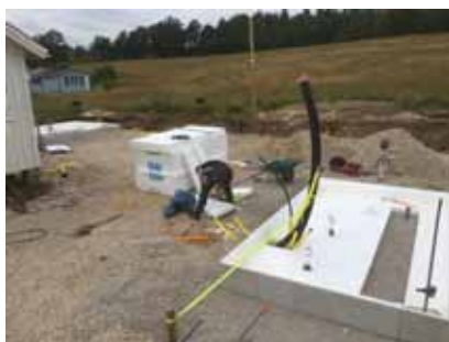
Första lagret med frigolit.
