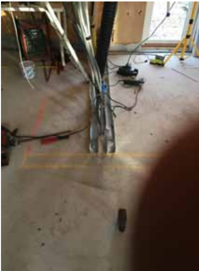
Här sätter min kompis Kenneth Norén dit golvet stålprofil. Profilen fästs med små spikmetallplugg. Det krävs därför 5mm borrningar i betongen med jämna mellanrum. Då bör man ta på sig hörselskydd - inte bara ha dem på huvudet :-)!
