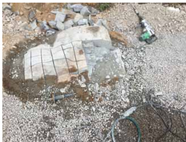
Göra snitt med en diamantklinga är lättare...
