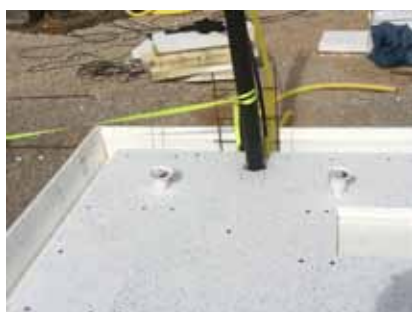
Extra betongficka för limträbalkstöd.
