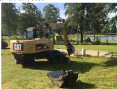
Det krävdes rejäla maskiner för att gräva...
