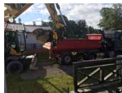
All matjord tas bort samt större stenar som är i vägen.
