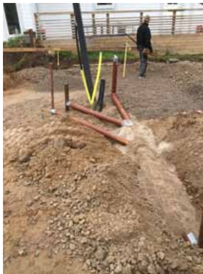
Avloppsrör till friggebodens avloppsbrunnar. Allt placeras i stenmjöl.
