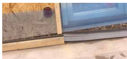
Styrlisten på plattan blir en stor hjälp för enkel montering. Samtidigt är den fästpunkten för blocken till plattan.
