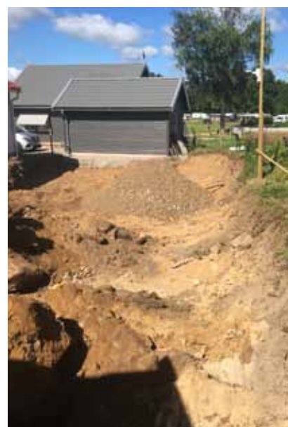
Därefter ska det återfyllas med rätt av nytt material kan påbörjas. Första lasset avlämnat.
