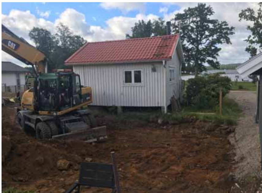
Nu är grävningen påbörjad för att nå fast mark.
