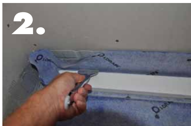
Här har flytspacklingen påbörjats och ska så småningom följas av att tätskickat ska monteras. Tack vare I-Drains förmonterade tätskickat blir förut-sättningarna för ett lyckat resultat så mycket lättare.
