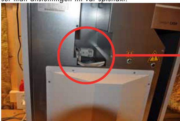
Här placeras den sensor som utför en stor del av regleringen till smartpanelen.
