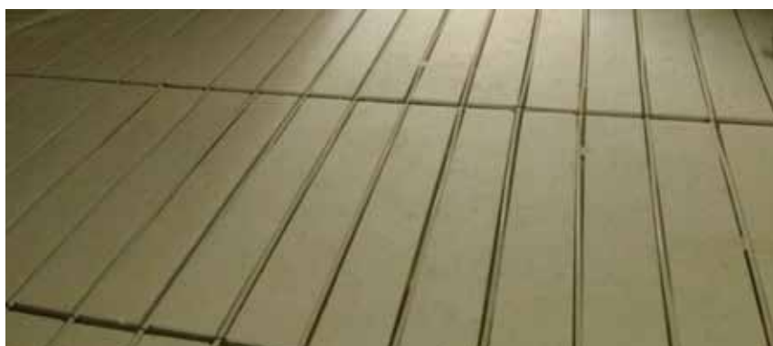
Här visas hur det ser ut efter utläggning av vattenrör och den armerade ESP:n.
